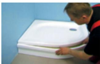
3/ Поддоны типа PU штампуются сразу вместе с панелью. У поддонов типа PAN или PP переднюю панель прикрепите к поддону. При применении поддона типа EX можно вместо панели просто облицевать плиткой.
