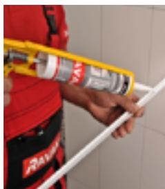
**4.** На внутренние части декоративной планки, которые примыкают к стене и к поверхности поддона/ванны, нанесите по всей длине силиконовый герметик толщиной 3мм.
