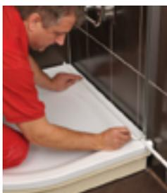
**2.** Отметьте длину декоративной планки по размеру поддона/ванны так, чтобы она примыкала к установочному профилю душевого уголка или доходила до края ванны.
