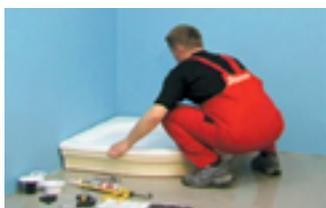
2/ Поддон установите в требуемое положение и придавите к полу так, чтобы силиконовый герметик плотно приклеился к полу. Не забудьте заранее прикрутить к стене пластмассовые крючки, которые стабилизируют положение поддона.
