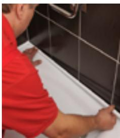
**5.** Вставьте декоративную планку в щель между поддоном/ванной и стеной так, чтобы она плотно прилегала к краю изделия и настенной плитке. Прижмите планку. После высыхания остатки силикона удалите.
