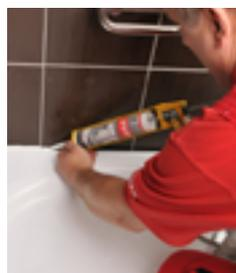
**3.** В стык между поддоном или ванной на пористую ленту нанесите силиконовый герметик толщиной 8 мм.
