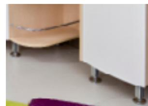
Устанавливается на регулируемые ножки на высоте 10 - 12 см.
