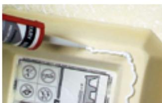
1/ Снизу наждачной бумагой отшлифуйте места стыковки поддона с полом. Затем нанесите на места стыковки силикон (по периметру поддона на расстоянии приблизительно 1 см от внешней грани носителя).
